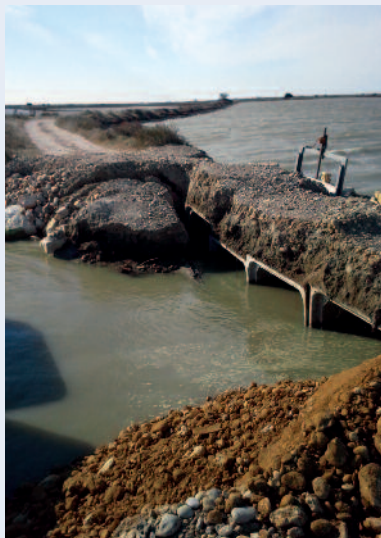
Restauration de la connexion hydraulique entre les étangs du Tampan et du Galabert.
